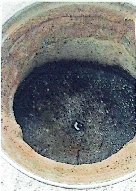
Colector principal de aguas servidas (cloacas)
